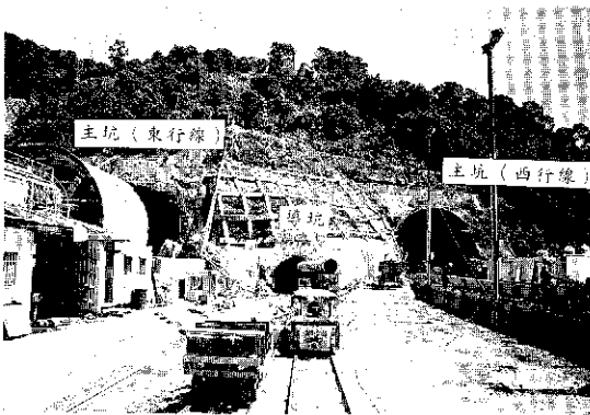
照片一 坪林隧道東洞口保護工完成後實景
