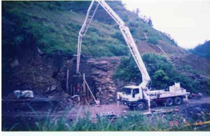
圖 4 北宜高速公路井式基礎施工
