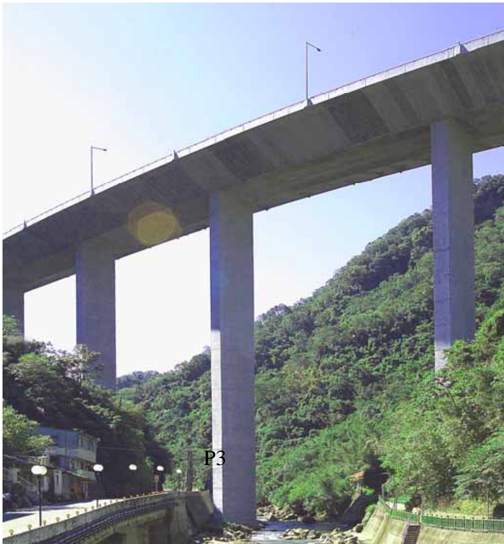
圖 2 北宜高速公路烏塗溪橋 P3 橋墩
