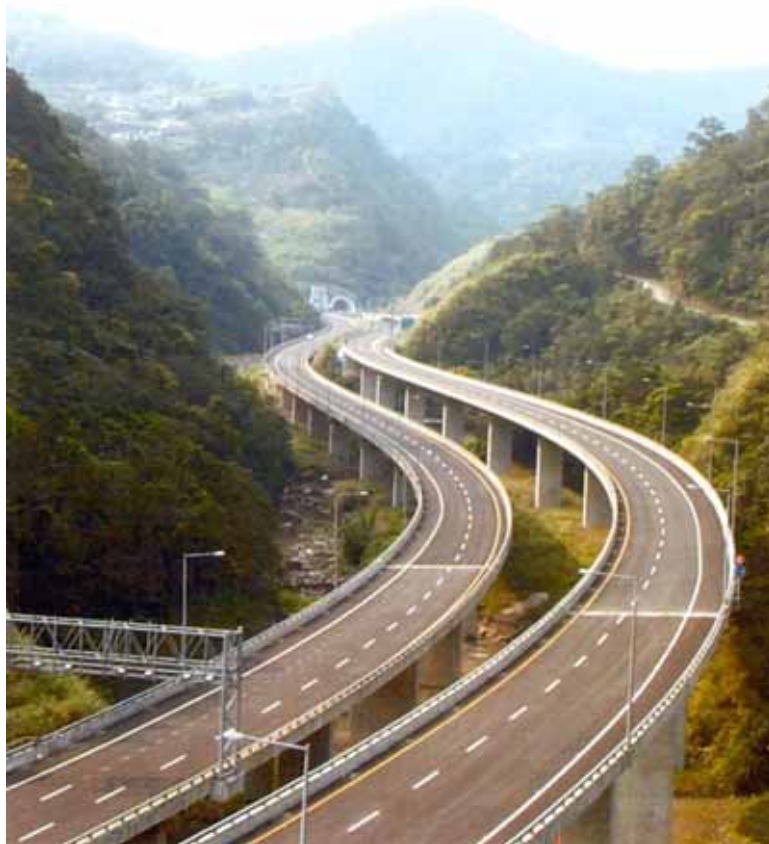
圖 3 北宜高速公路坪林高架橋
