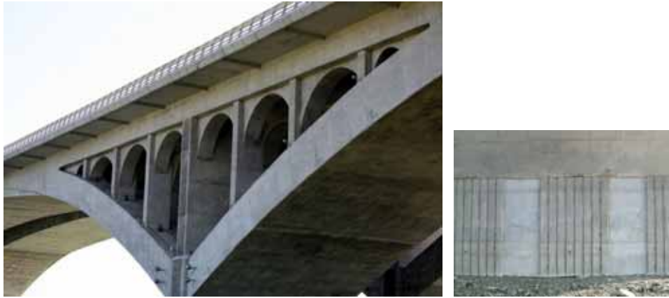
圖 15 冬山河橋主橋墩上之層次設計及橋墩造型模板完工照片
