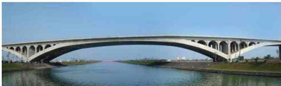
圖 14 冬山河橋完工照片
