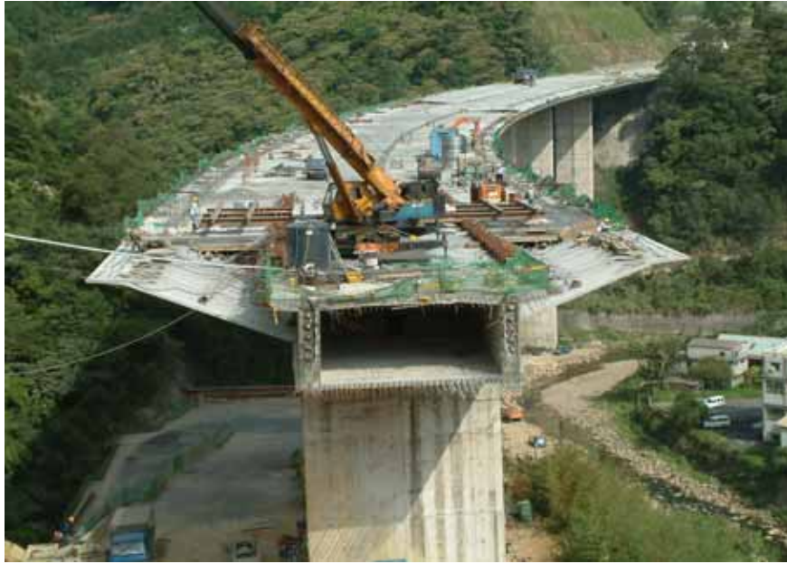
圖 5 北宜高速公路上構施工
